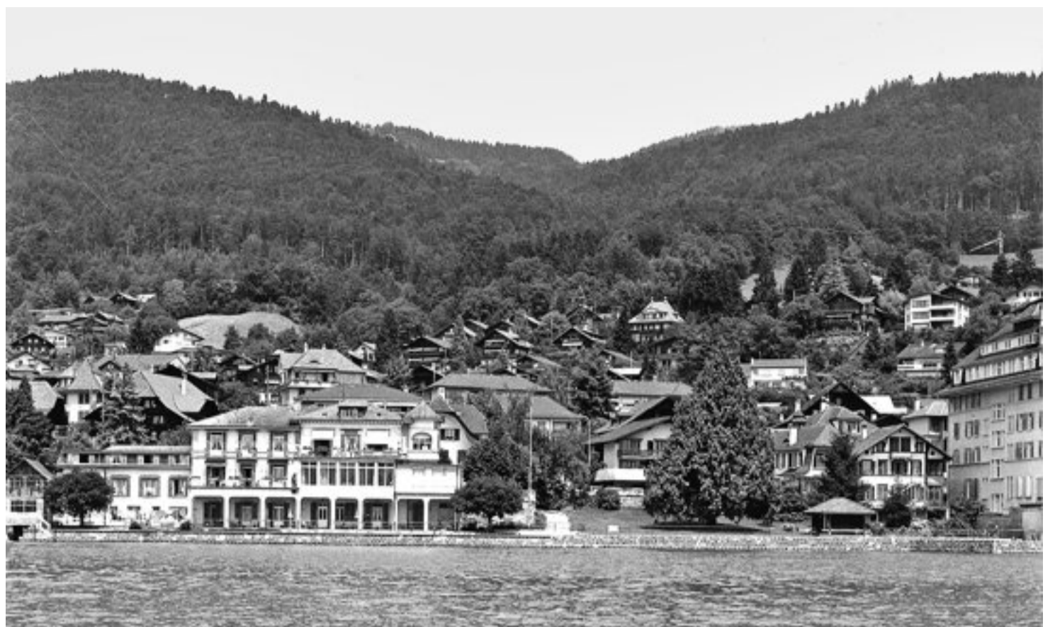
So präsentierte sich das Altersheim Magda zwischen den 1950er-Jahren und 1992. Das 1994 fertig errichtete Wohnheim fügte sich südlich (auf dem Bild rechts) an die Villa Magda an. Der in den 1950ern errichtete Anbau (linker Bildrand) wurde 2013/2014 durch einen neuen Anbau ersetzt. Bilder: zvg
